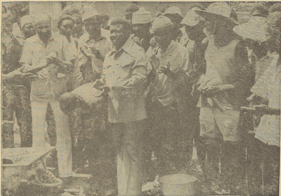
O camarada Victor Saúde Maria usando da palavra na cerimónia de lançamento da 1.ª pedra da construção de um bairro para os trabalhadores das Obras Públicas. À esquerda o camarada Tino Lima Gomes, Ministro das Obras Públicas
